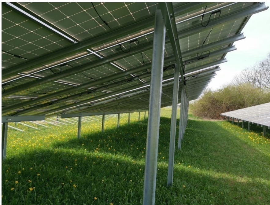
Figura 7 Tipico strutture di sostegno
